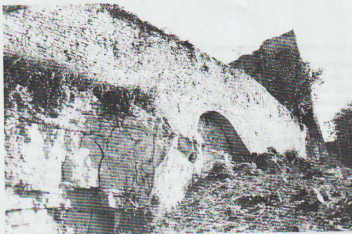
Le rempart de l'Ouest et son arc de décharge.
