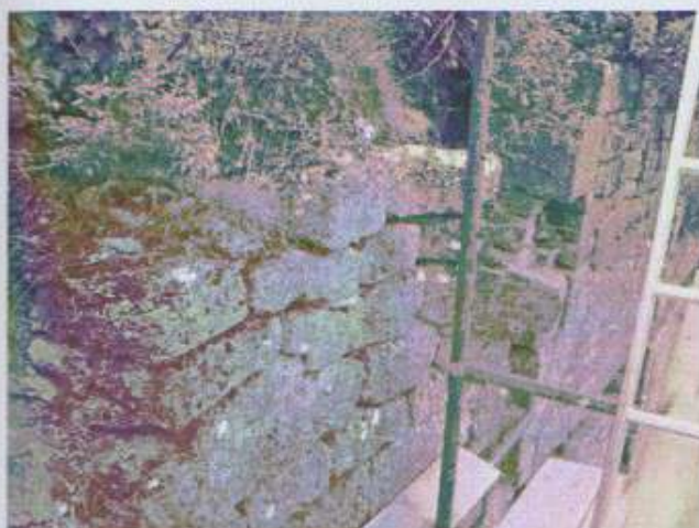
Photo n°51 : Instabilité du parement Intérieur, des pierres menacent de s'effondrer
