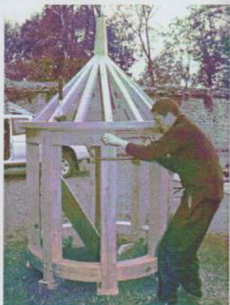
Photo n°31 Fabrication de la charpente du lanterneau du pigeonier par Emmanuel Martin
