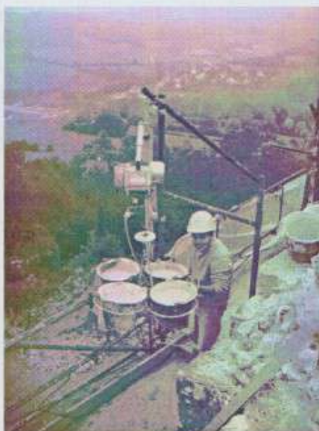
Photo n°37 Gaëtan Bernet à la réception des seaux de mortier montés par le treuil
