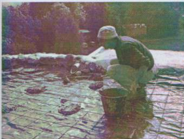
Photo n°53 : Une des évacuations en cuivre. Bernard Maingard disposant le treillis soudé sur des plots de mortier
