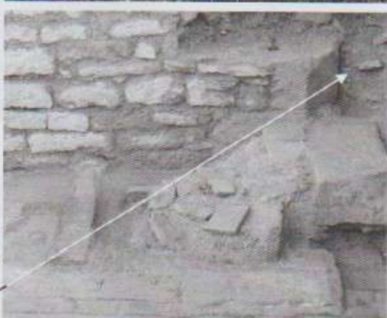
Photo n°64 Mise au jour de l'ébrasement dans le mur de refend
