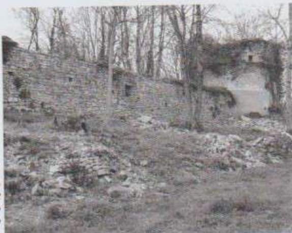
Photo n°44 Mur de soutènement de la terrasse non restauré
