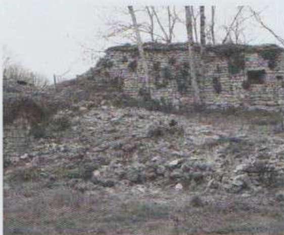
Photo n°39 Mur éboulé de la terrasse de la basse cour
