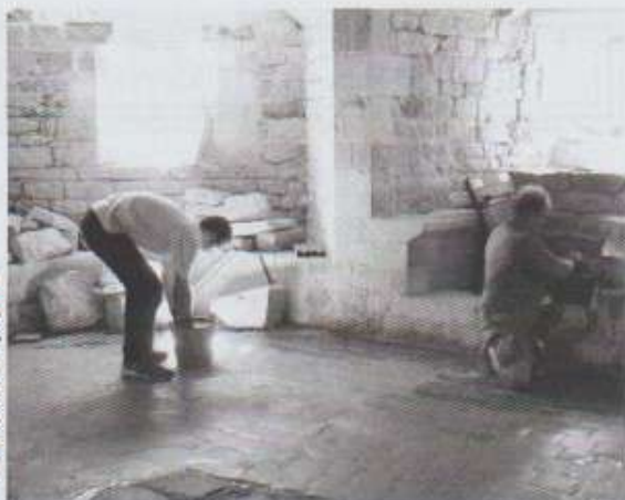
Photo n°26 Remplissage des joints par Stéphane Frambourg aidé de Guillaume Poulain.
