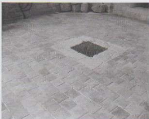
Photo n°27 Le pavage terminé Au centre la trappe du cul-de-basse-fosse
