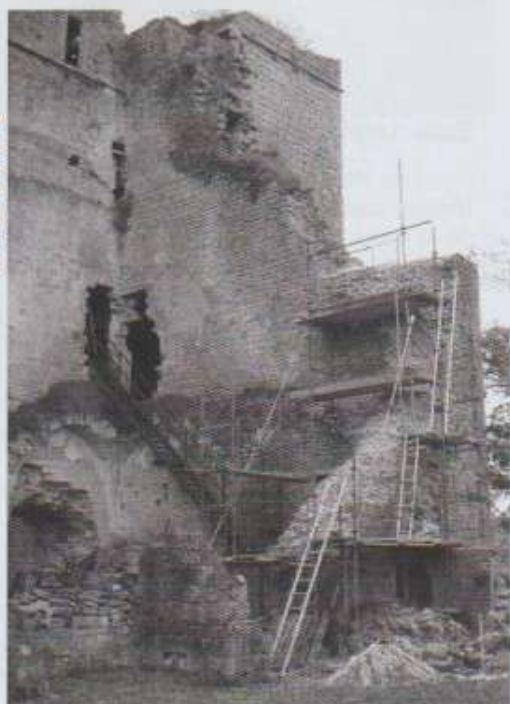
Photo n°30 Echafaudage au- droit des murs ouest et nord de la salle seigneuriale et de la salle des gardes.
