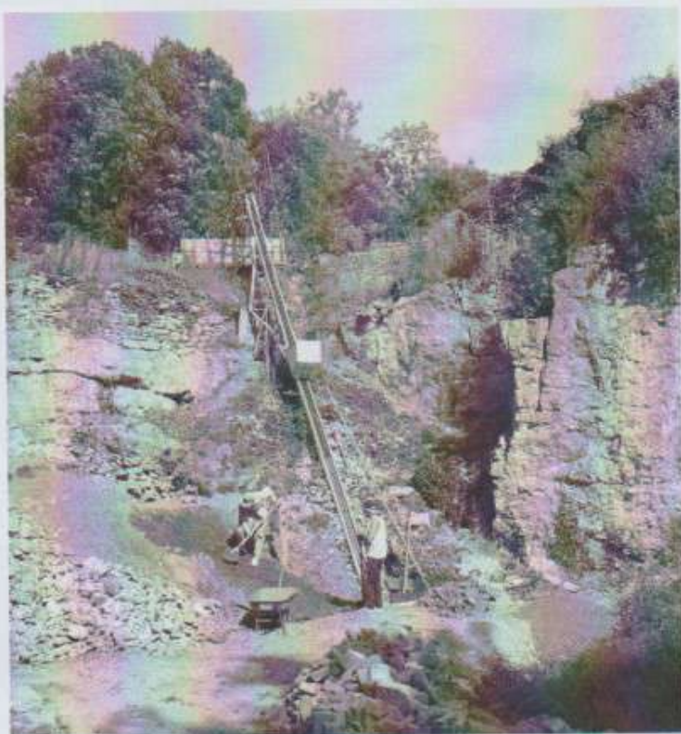
Le monte charge en train de sortir du fossé une benne de gravats André Cherblanc et Robert Broisseau au chargement de la brouette
