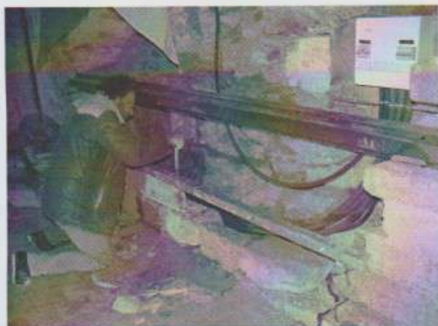
Bruno Lachaume comble le trou pour masquer l'appareillage électrique
