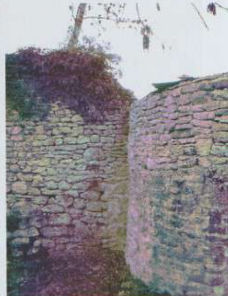
Le mur de la tour ouest en partie remonté, vu de l'extérieur, à gauche en entrant.
