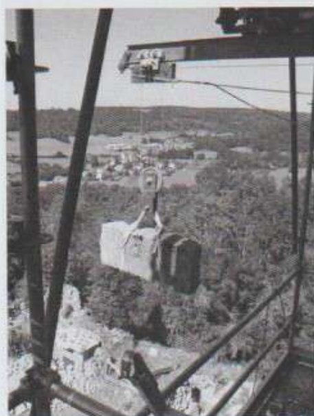
Photo de Gauche : le treuil installé permet de monter les pierres taillées au niveau du trou de cheminée.
