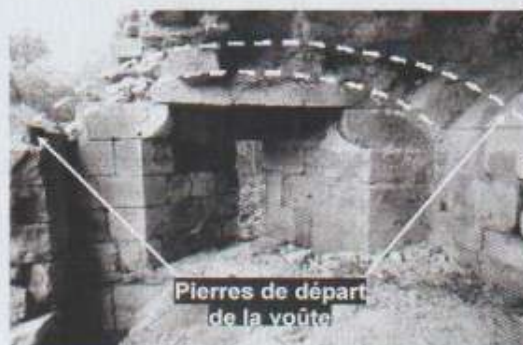
Meurtrière est de la salle du rez-de-chaussée de la tour de l'est avec le tracé de la voûte à reconstruire.
