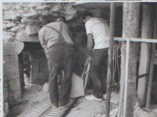
Photo de droite Bruno Lachaume, Mathieu Dubost et Alexandre Bélieff mettant en place une pierre taillée pour la sceller dans la meurtrière du rez-de-chaussée de la tour Est
