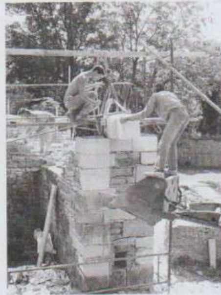
Photo du centre : Alexandre Béliaeff mettant en place une pierre qu'il vient de tailler sur le pilier du mur gauche d'entrée de la basse-cour.
