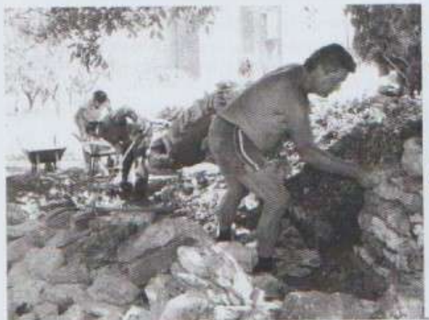
Reconstruction du mur en pierres sèches jouxtant la citerne de la basse-cour
