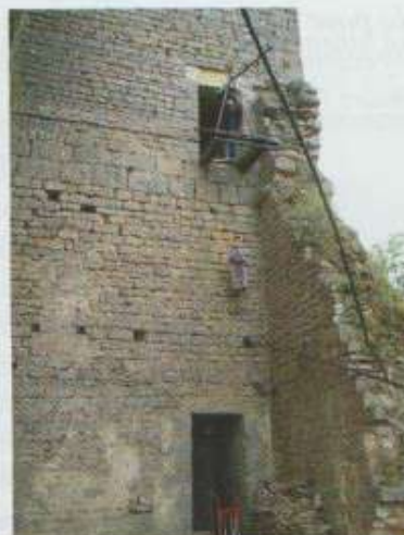
Pierre de taille montée au treuil au premier étage de la tour Amélie par André le 6 août (photo G. Poullain)
