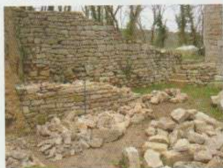
Mur de soutènement bâti par Gérard pour soutenir les fondations du mur Rg
