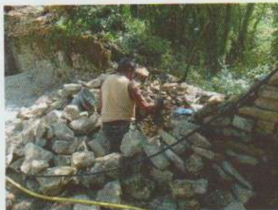
Gérard dégage les fondations du mur effondré avant de le remonter en pierres sèches
