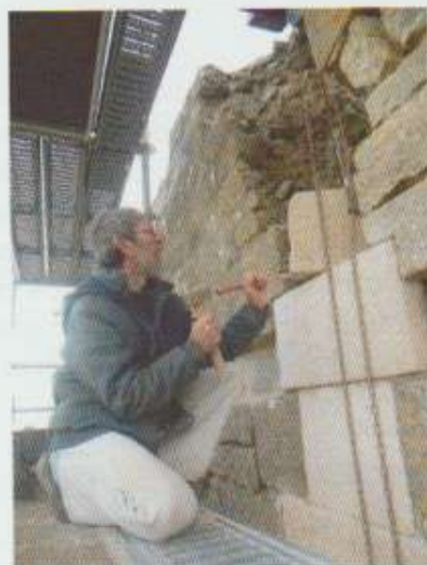
En préalable à son installation, André taille une pierre pour le conduit de cheminée
