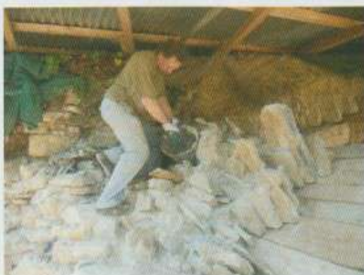
Bruno en position dynamique pour le bourrage au mortier du départ de la voûte
