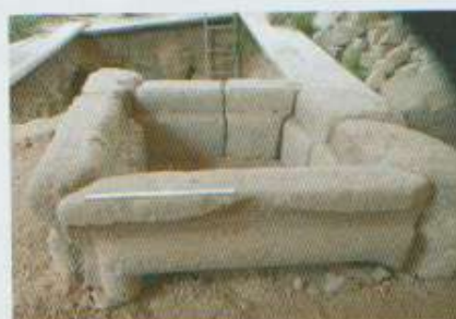
Pierres d'encadrement d'une fenêtre réutilisées pour former la trappe d'accès à la salle inférieure de la tour de l'Est A2
