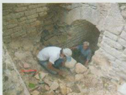
Reprise d'un bout de mur pour sécuriser l'accès au puits des latrines, André et Robert
