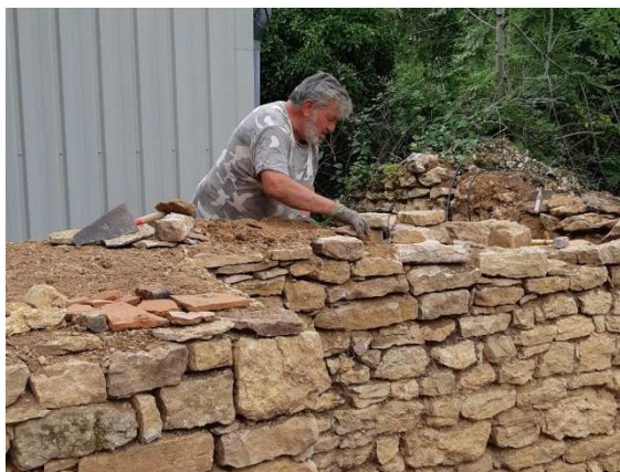
Gérard V. reconstitue partiellement en pierres sèches le mur oriental des soues...
