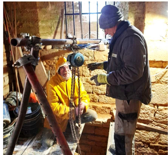
Le même travail est effectué (au sec) dans la chambre de tir des latrines (salle De), où une "chèvre" et un treuil sont mis en place. (André et Gérard P.).
