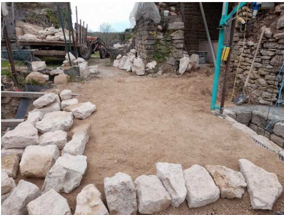
Cet espace, protégé des infiltrations d'eau par une toile imperméable, puis couvert d'une couche de sable, permettra dans un premier temps de stocker les "belles pierres" remontées de la salle inférieure.
