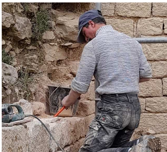
Alexandre retaille quelques pierres nécessaires à la consolidation des murs dégagés.
