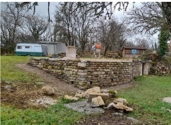
Dans la basse-cour le muret de soutènement autour de la citerne s'élève peu à peu.
