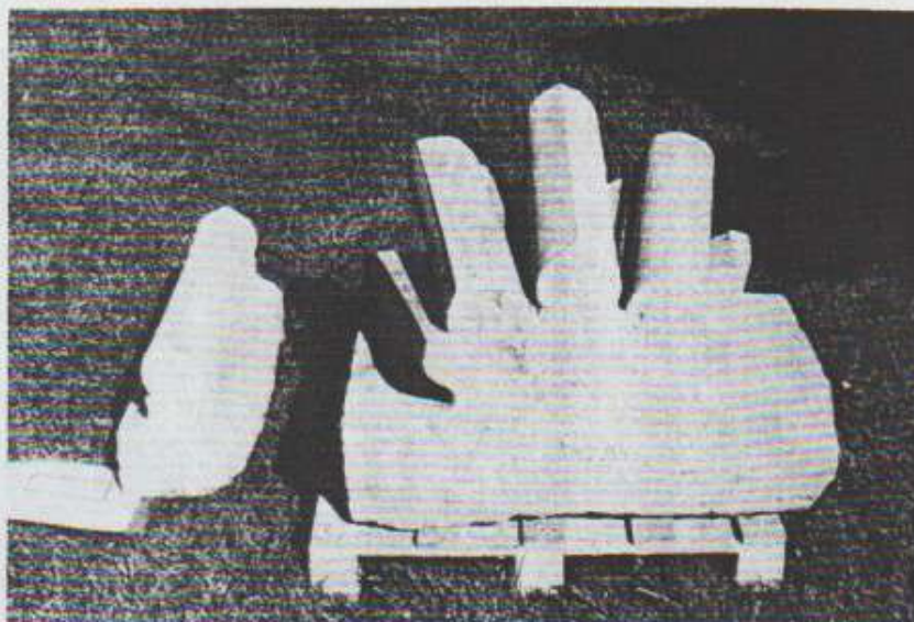
Photo N°3. Claveau d'arc-ogive et bloc de départ des arcs-formerets, des arcs-ogives et de l'arc-doubleau de la voûte de la chapelle castrale.
