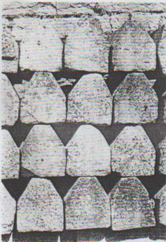
Photo n°30. Claveaux de croisées d'ogives en calcaire à entroques.
