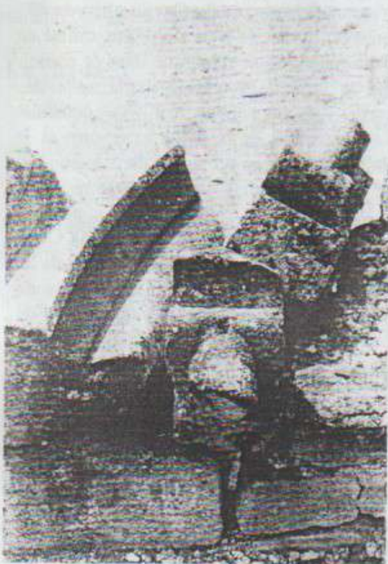
Photo n°35. Eléments lapidaire en calcaire oolithique non gélif.
