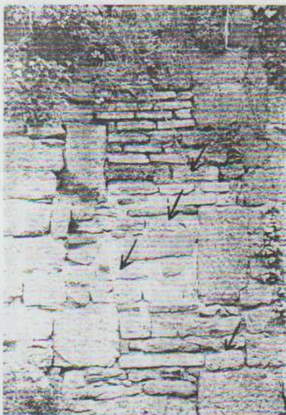
Photo n°38. Moellons en tuf (Conduit de cheminée de la salle supérieure de la tour Amélie).
