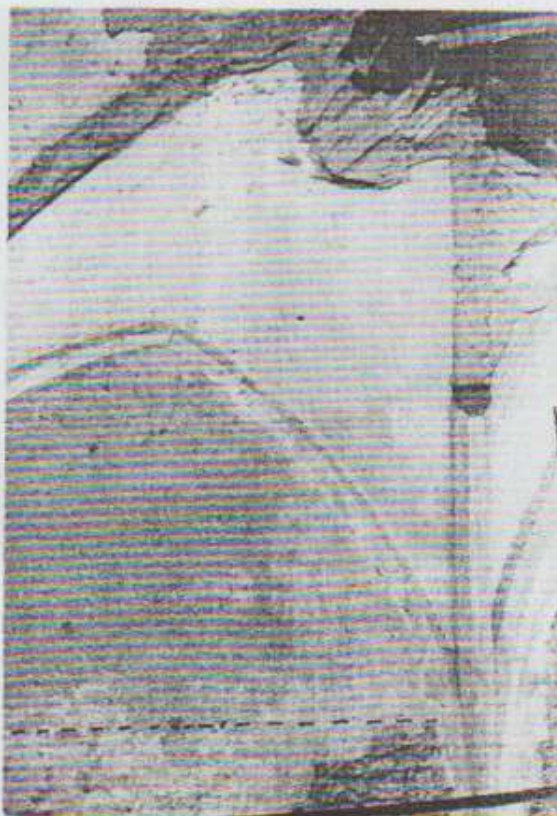
Photo n°1. La présence du plancher est matérialisée par la disparition de l'enduit (pointillés)
