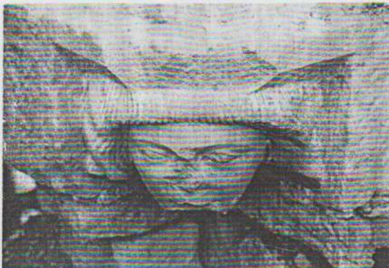
Photo n°37. Culot de lampe en calcaire oolithique plus ou moins gélif.
