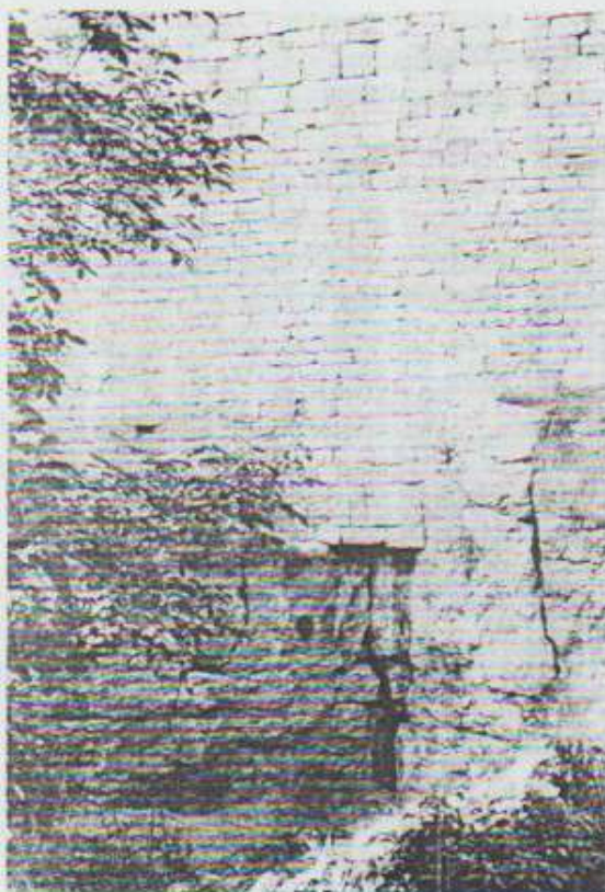
Photo n°19. La courtine bien ancrée sur le socle rocheux.
