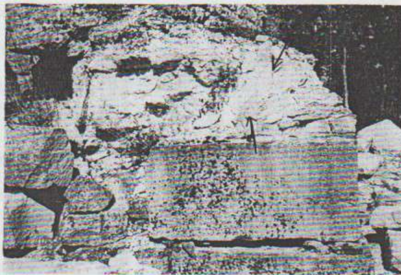
Photo n°34. Moellon en calcaire oolithique (oolithique blanche) dégradé par le gel.
