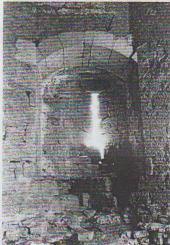
Photo n°31. Cintre en calcaire à entroques tranchant avec le calcaire marbre.
