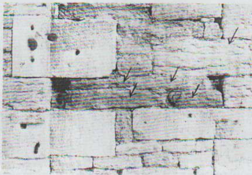
Photo n°28. Moellons de calcaire granulaire sous l'entrée ogivale (Flèches)
