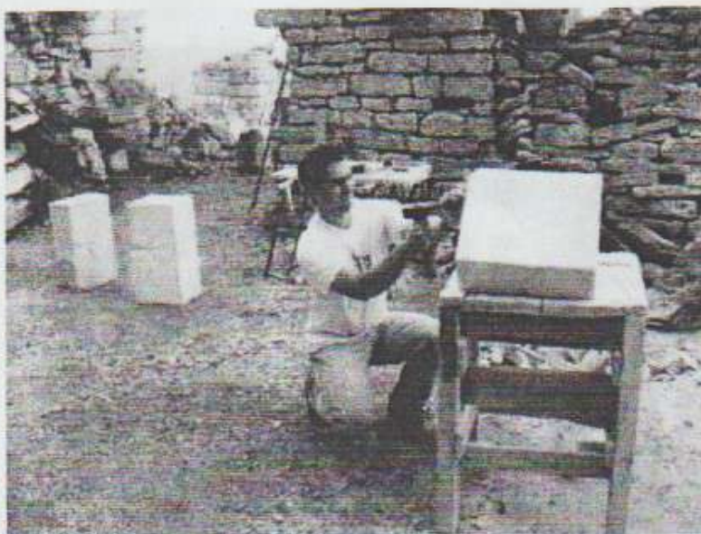
Photo n°28. Hervé COLIN taillant un voussoir.
