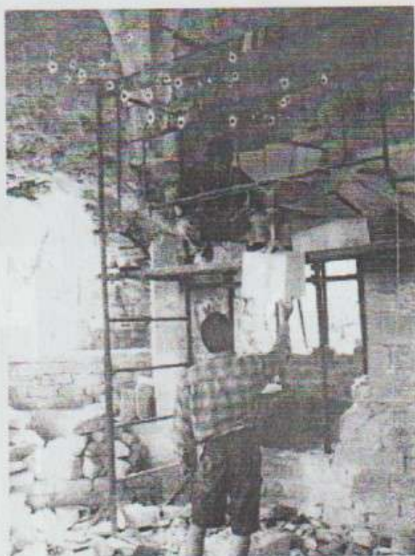
Photo n°13. Confection de la voûte de la niche de la baie Ouest. Bernard MAINGARD et Nicolas ROUSSELET montent un voussoir.
