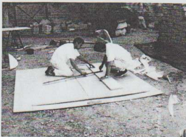
Photo n°25. Bernard MAINGARD et Hervé COLIN traçant le cintre destiné à soutenir la voûte de la niche de la baie Ouest.
