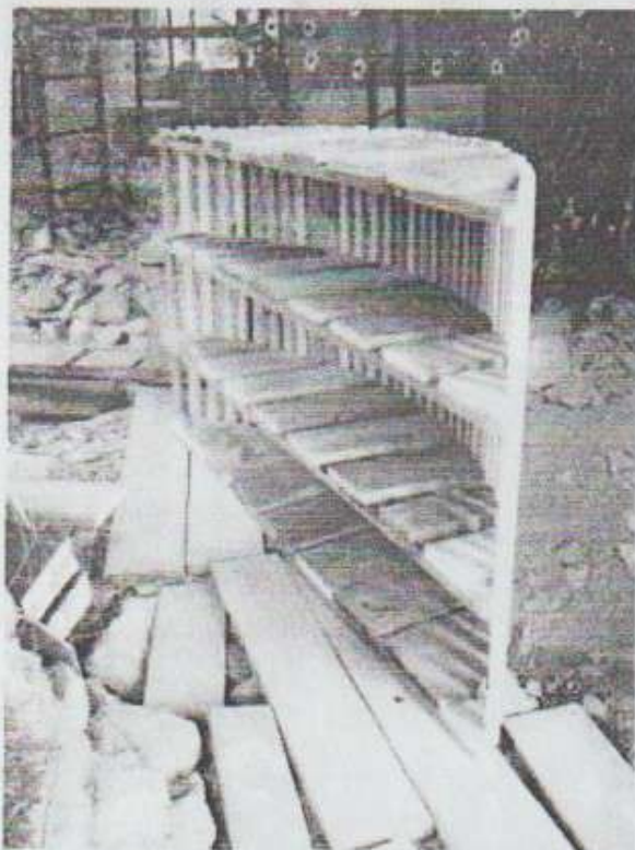
Photo n°16. Cintre de support de la voûte de la niche Sud Ouest prêt à être posé.
