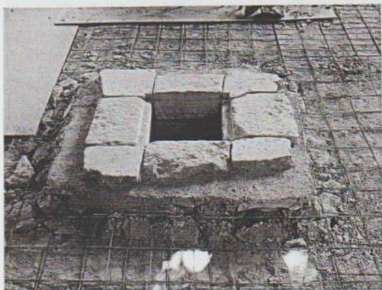
Photo n°9 Trappe d'accès au cul de basse-fosse remontée
