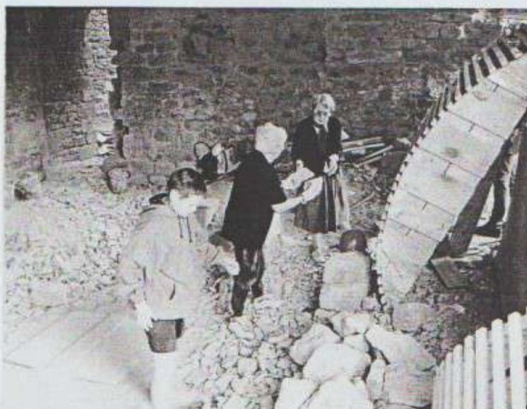
Photo n° 6 Remblaiement du sol du rez-de-chaussée de la tour Amélie
