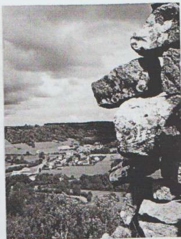
Photo n° 16 Parement extérieur du haut du mur de la tour de l'Est. Les pierres sont prêtes à tomber (Au loin, vue sur Villiers)
