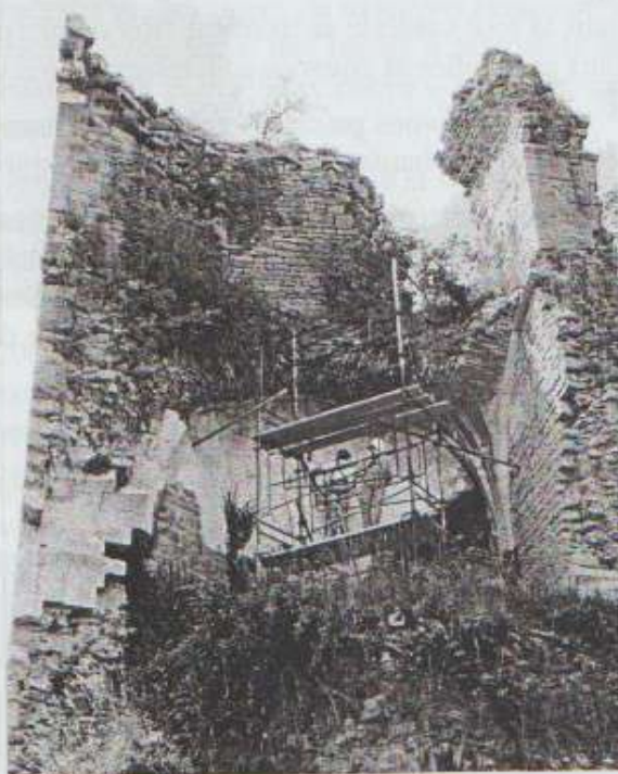
Photo n°23. Seconde colonne d'échafaudage
