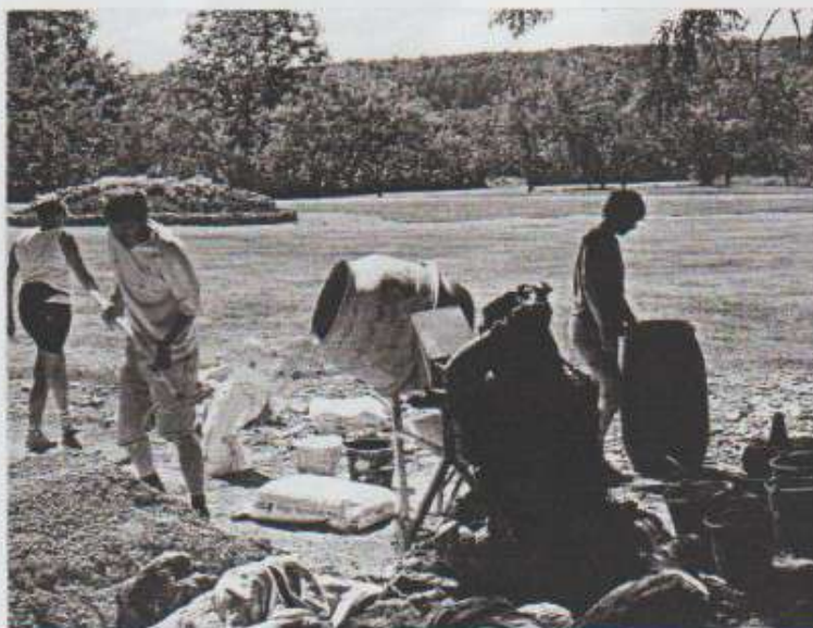
Photo n° 14 Confection du mortier pour la réfection du rempart Est de la basse-cour
