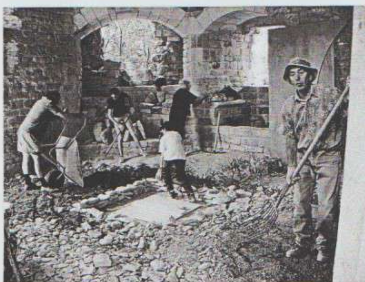
Photo n° 7 Nivellement du sol du rez-de-chaussée de la tour Amélie
