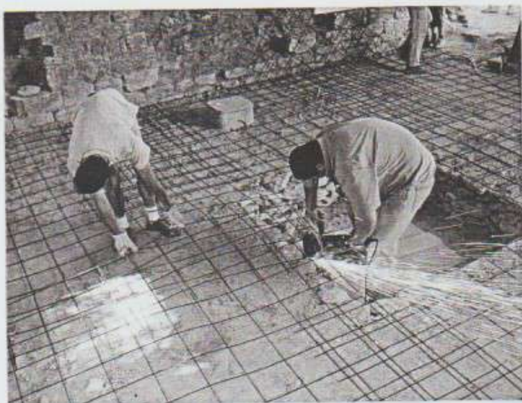
Photo n° 8 Pose d'un treillis métallique sur le sol remblayé
