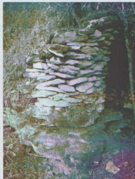
Détail des pierres s'appuyant sur le rocher
