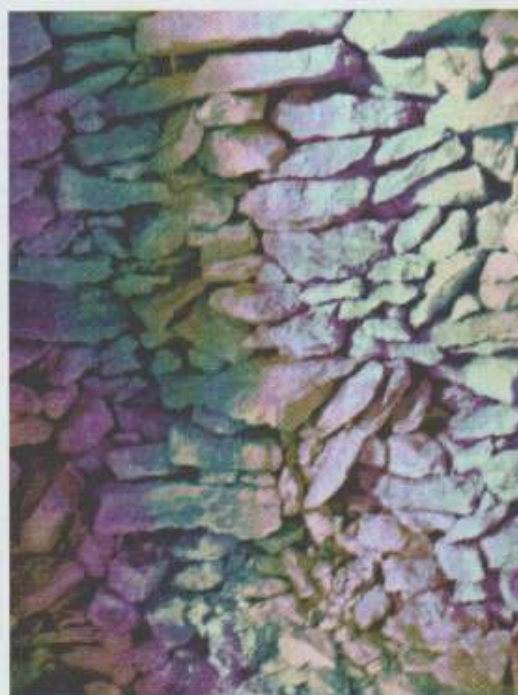
Vue de l'intérieur montrant la disposition peu soignée des pierres
