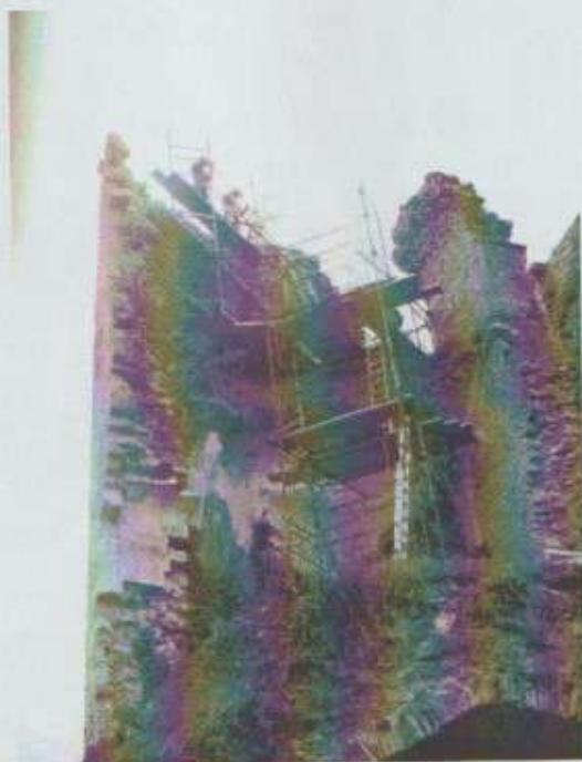
Photo n°5 L'échafaudage de la tour de l'Est édifié à partir du premier étage
