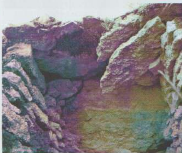
Dalles en cours de déboîtement au dessus de l'entrée.
