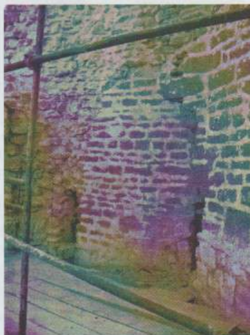
Photo n°32 Détail du parement intérieur jointoyé
