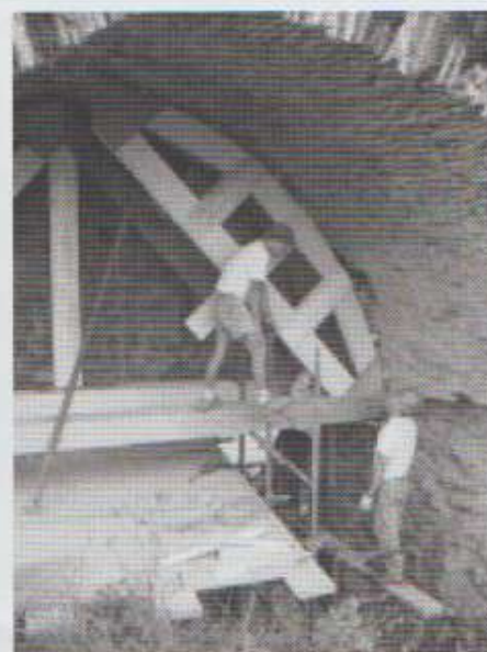
Photo n°34 Assemblage des fermes
