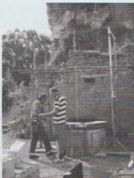
Photo n°19 Portique pour remonter la pompe
