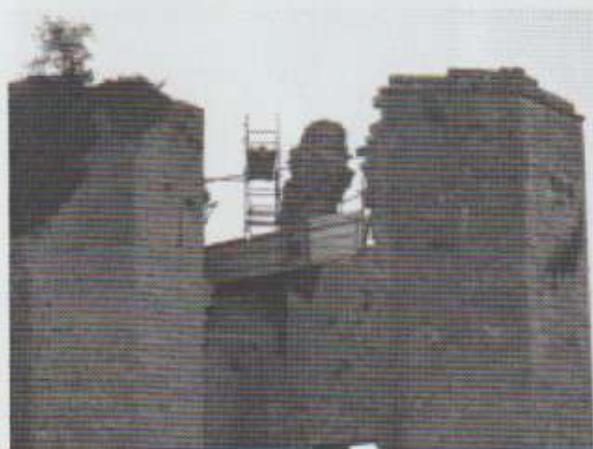
Photo n°37 Montage d'échafaudage pour consolider le moignon
