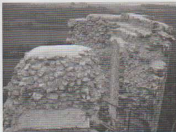
Photo n°38 La calotte en béton sur la tête du moignon
