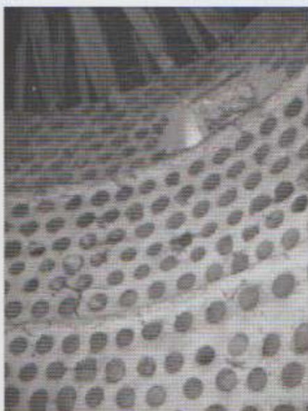
Photo n°56 Cases en poteries et enduit à la chaux à Montigny-Montfort
