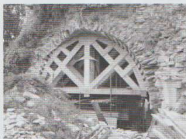
Photo n°35 Dispositif de soutènement de la voûte du rez-de-chaussée de la tour de l'Est.
