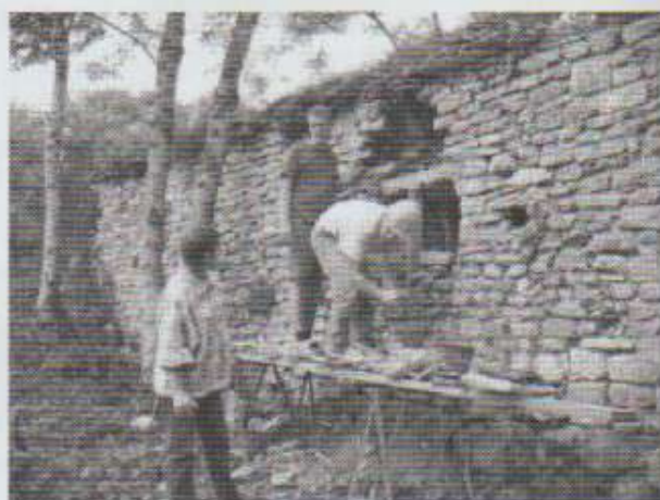
Photo n°35 Réparation d'une meurtrière sur le rempart Sud de la basse-cour
