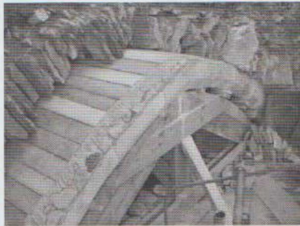
Photo n°41 Planches de coffrage pour reconstitution des voûtains
