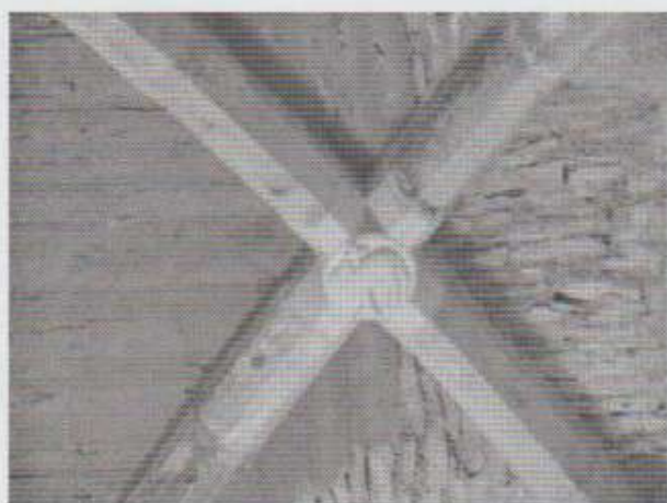
Photo n°34 La voûte de la salle basse de la tour Amélie décoffrée
