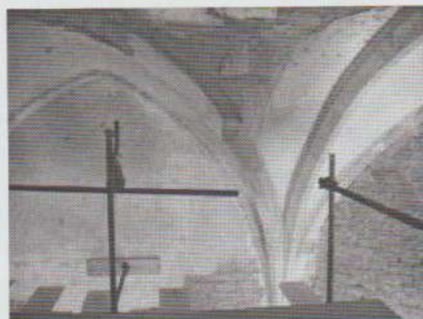
Photo n°52 Vue prise de l'échafaudage d'un arc de la croisée d'ogives partiellement détruit
