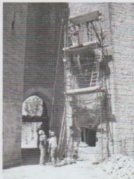
Photo n°15 Montée des pierres au 2 ème étage
