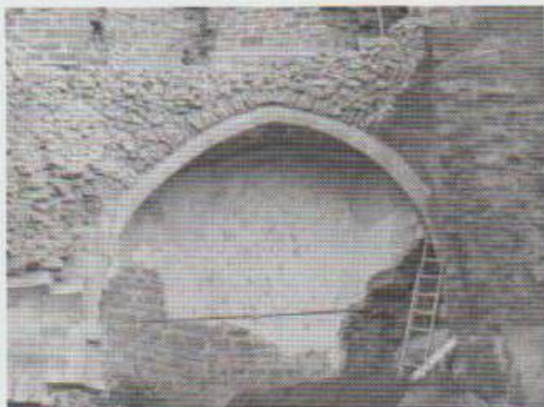
Photo n°44 La voûte partiellement reconstituée avec son arc doubleau
