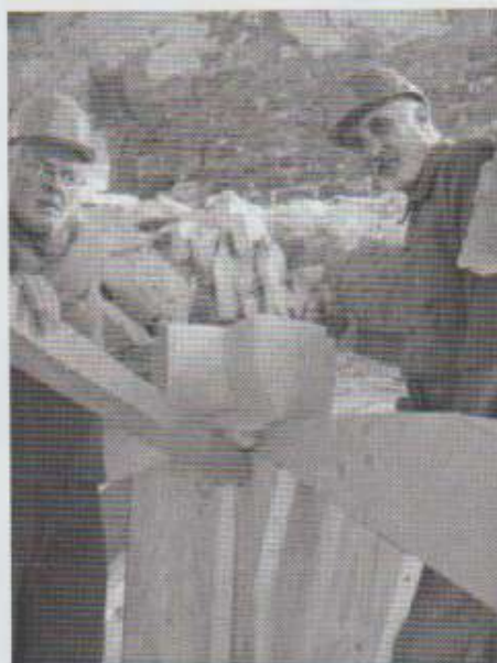
Photo n°54 La clef de voûte supportée par les cintres
