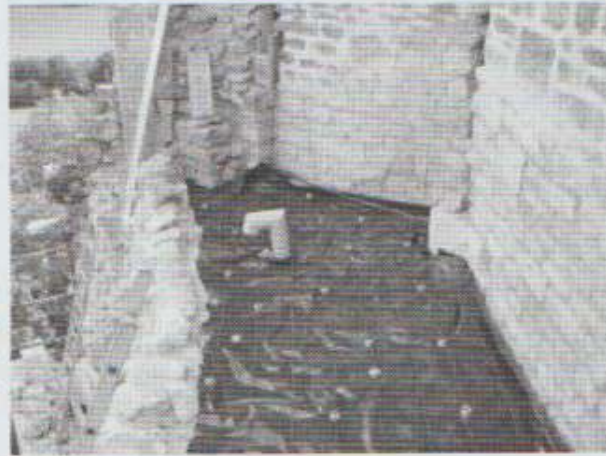
Photo n°43 Pose du film étanche et du treillis avec les deux aérations
