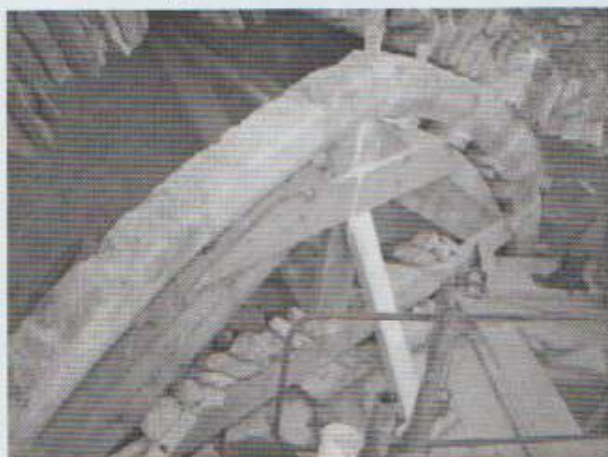
Photo n°40 Calage des voussoirs de l'arc doubleau sur le cintre
