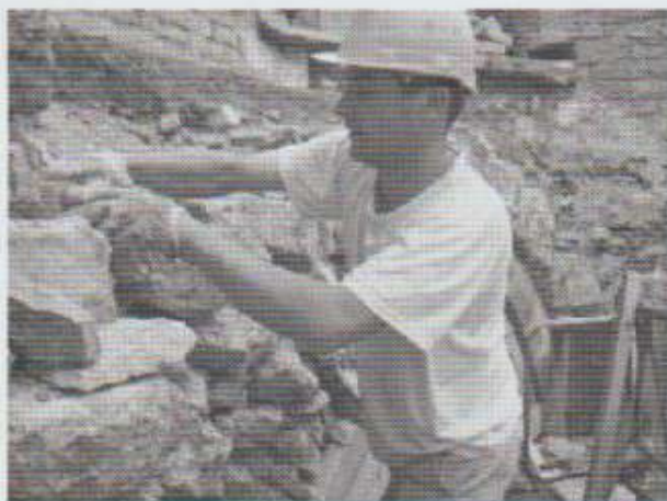
Photo n°11 Maçonnerie de la voûte du 1 er étage de la tour de l'Est
