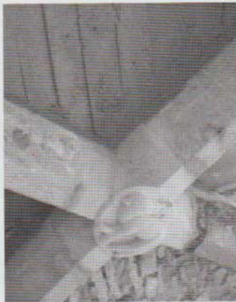
Photo n°55 La clef de voûte en place
