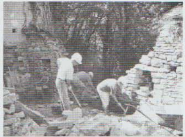
Photo n°49 Dégagement de la courtine de la basse-cour en voie d'éboulement (Près du pigeonnier)
