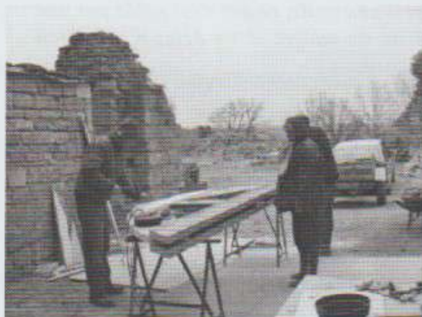
Photo n°1 Fabrication d'un cintre en bois
